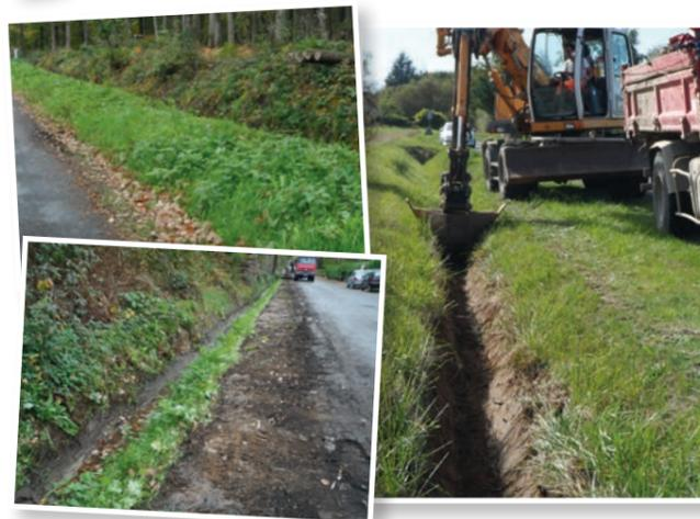
Curage des fossés et reprofilage pour certains sur 2 880 mètres linéaires. L'accotement des fossés a également été dérasé sur 400 mètres linéaires pour maintenir les profils d'écoulement des eaux pluviales.
