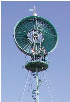
Cette éolienne avait la particularité d'être équipée d'une turbine comprenant un stator (A) et un rotor (B).
